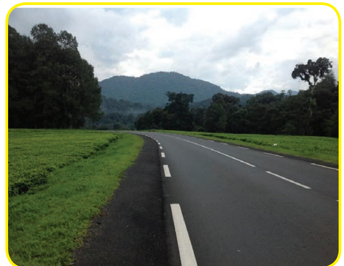
La route goudronnée construite à travers la forêt de Nyungwe pour connecter le Cyangugu au reste du pays a fragmenté la forêt en deux parties. Photo: Kambogo Ildephonse
