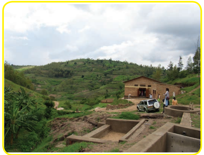
Système de traitement d'eau en cours de construction pour résoudre le problème de la pollution. Photo: ARCOS
